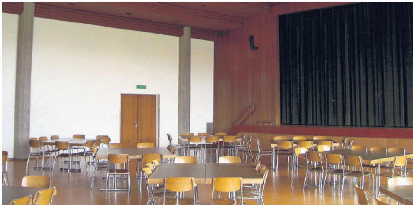
Der 30jährige Buchensaal in Speicher soll saniert werden. Der Gemeinderat hat einen Projektierungskredit bewilligt.
