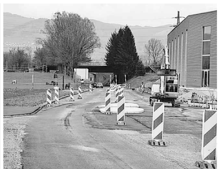
Die Bauarbeiten am Autobahnzubringer schreiten voran.
